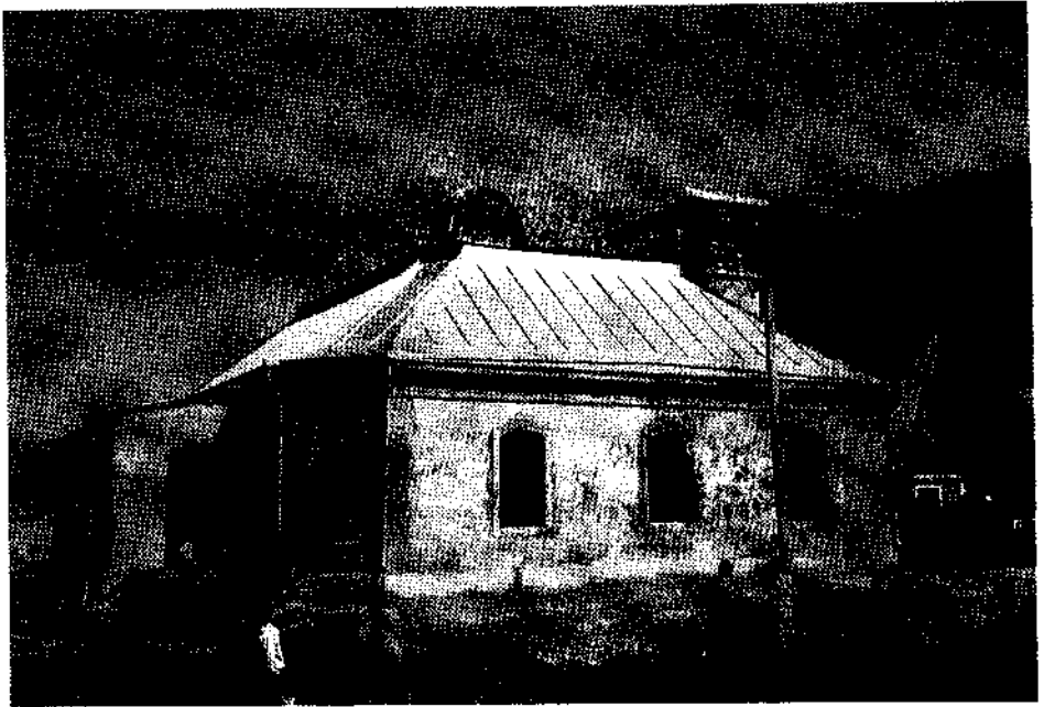
مسجد بلدة كندلن
